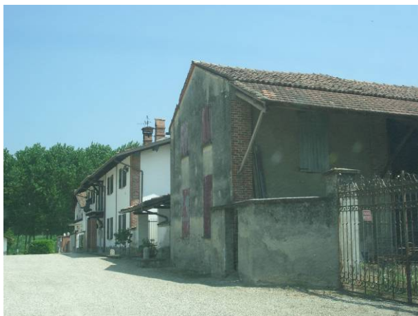
Edificio n° 5 – foto n° 91 Isolato n° 16
