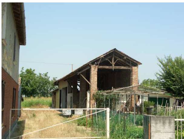
Edificio n° 4 – foto n° 82 Isolato n° 10
