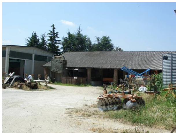
Edificio n° 10 – foto n° 11 Isolato n° 1
