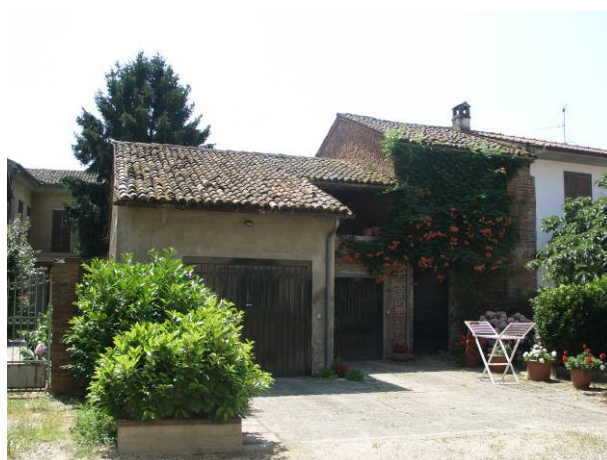
Edificio n° 6 – foto n° 03 Isolato n° 1
