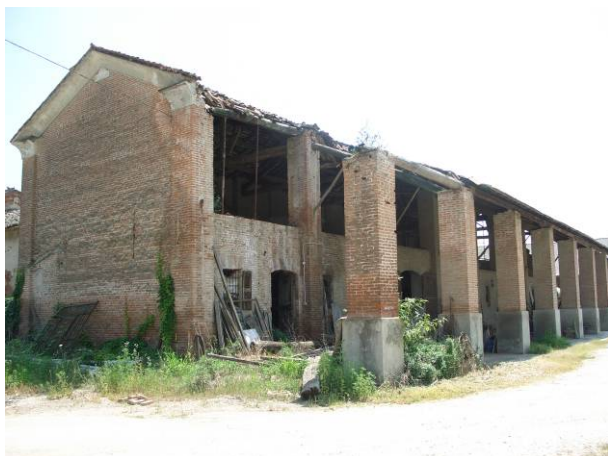
Edificio n° 6 – foto n° 05 Isolato n° 14
