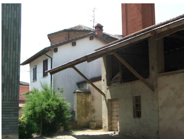
Edificio n° 6 – foto n° 51 Isolato n° 2
