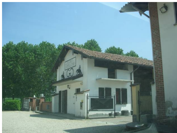
Edificio n° 6 – foto n° 93 Isolato n° 16
