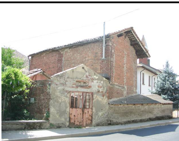
Edificio n° 8 – foto n° 40 Isolato n° 3
