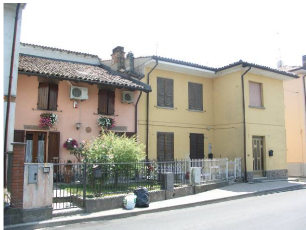
Edificio n° 5 – foto n° 78 Isolato n° 6
