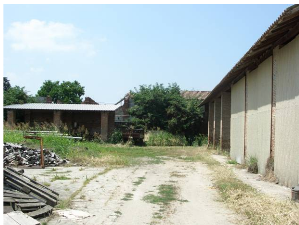
Edificio n° 11 – foto n° 11 Isolato n° 14
