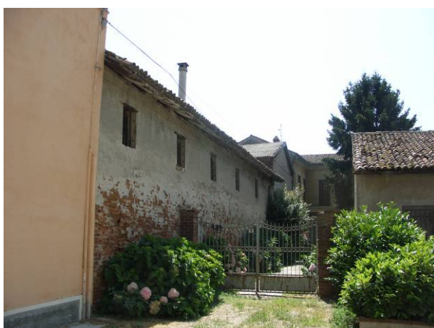
Edificio n° 5 – foto n° 02 Isolato n° 1
