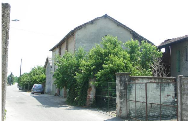
Edificio n° 3 – foto n° 86 Isolato n° 7
