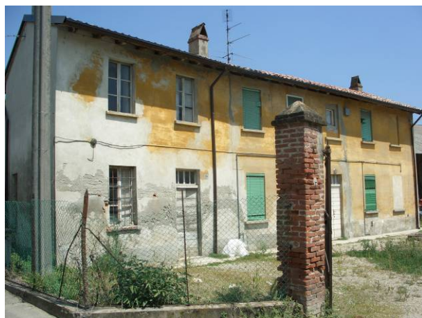
Edificio n° 6 – foto n° 31 Isolato n° 4
