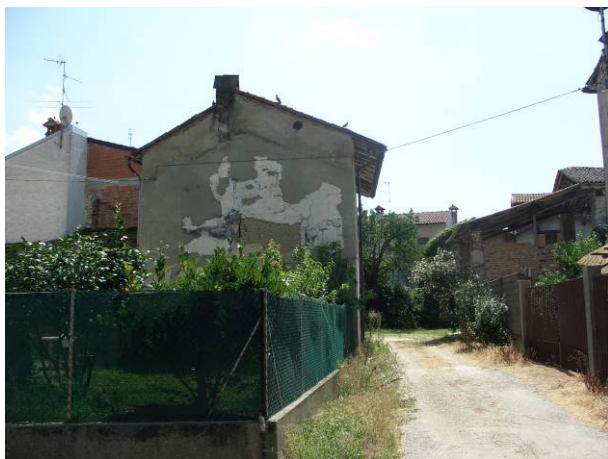
Edificio n° 2 – foto n° 58 Isolato n° 5
