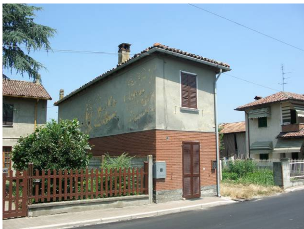
Edificio n° 1 – foto n° 81 Isolato n° 10
