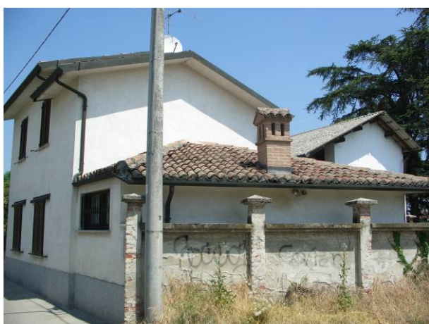
Edificio n° 13 – foto n° 37 Isolato n° 4
