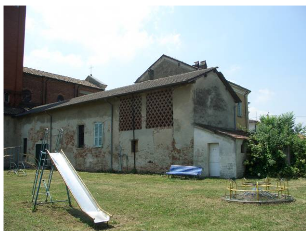
Edificio n° 7 – foto n° 53 Isolato n° 2
