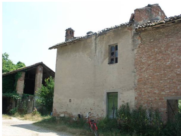
Edificio n° 5 – foto n° 02 Isolato n° 14
