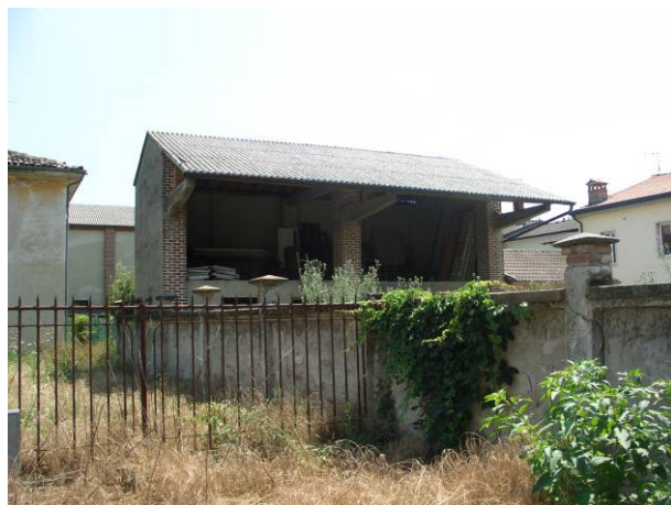
Edificio n° 16 – foto n° 35 Isolato n° 4
