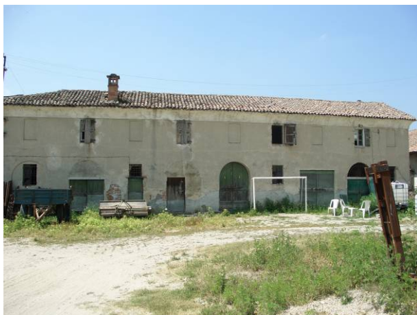
Edificio n° 8 – foto n° 07 Isolato n° 14
