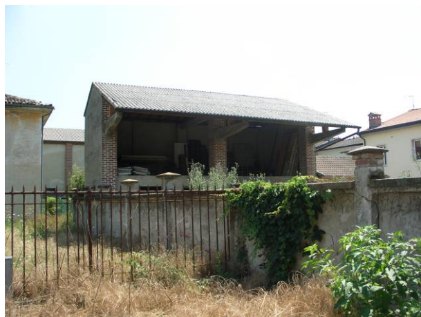
Edificio n° 8 – foto n° 35 Isolato n° 4
