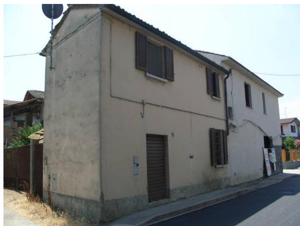
Edificio n° 1 – foto n° 57 Isolato n° 5
