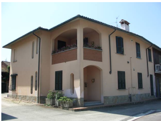
Edificio n° 3 – foto n° 97 Isolato n° 1
