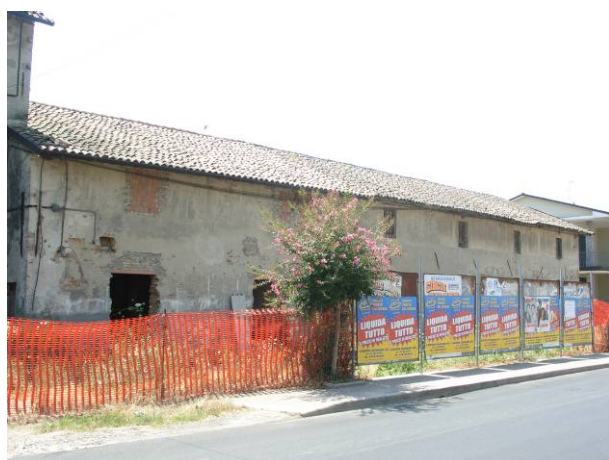
Edificio n° 13 – foto n° 25 Isolato n° 14
