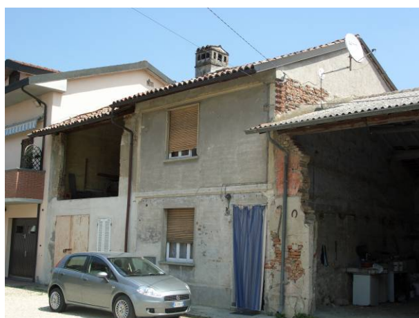
Edificio n° 5 – foto n° 46 Isolato n° 3
