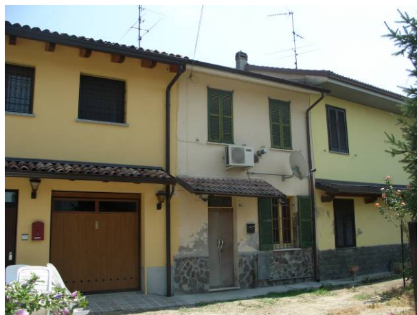
Edificio n° 1 – foto n° 44 Isolato n° 3
