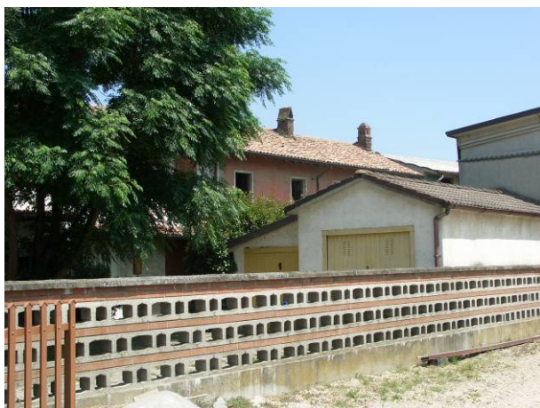
Edificio n° 11 – foto n° 39 Isolato n° 4
