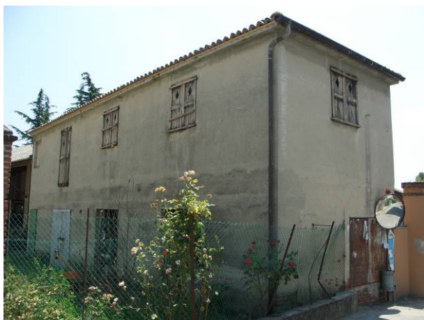
Edificio n° 5 – foto n° 30 Isolato n° 4
