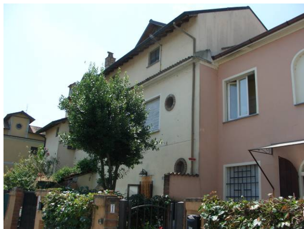
Edificio n° 24 – foto n° 27 Isolato n° 4
