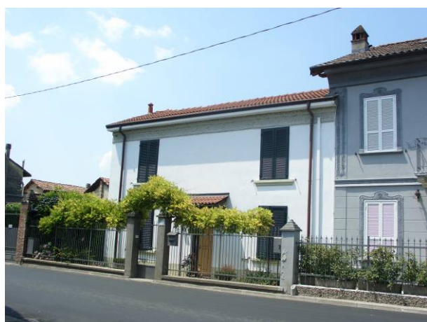
Edificio n° 4 – foto n° 74 Isolato n° 8
