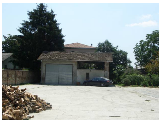
Edificio n° 12 – foto n° 10 Isolato n° 1
