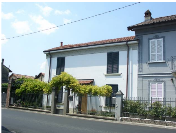
Edificio n° 1 – foto n° 84 Isolato n° 8
