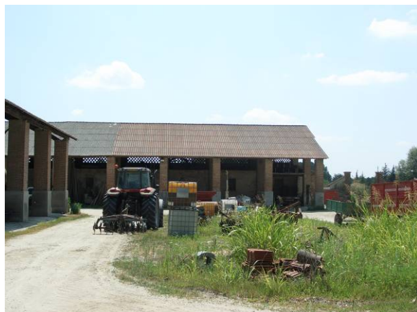
Edificio n° 7 – foto n° 06 Isolato n° 14
