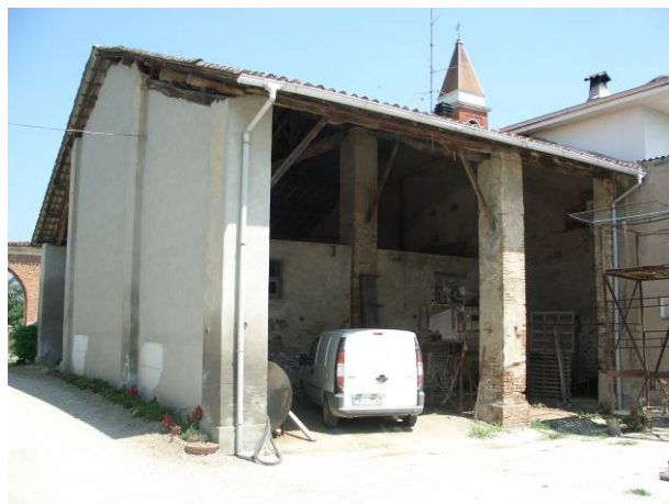
Edificio n° 14 – foto n° 14 Isolato n° 1
