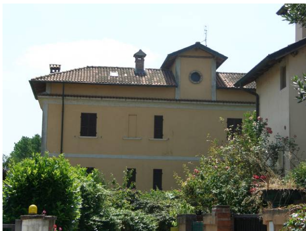
Edificio n° 23 – foto n° 28 Isolato n° 4
